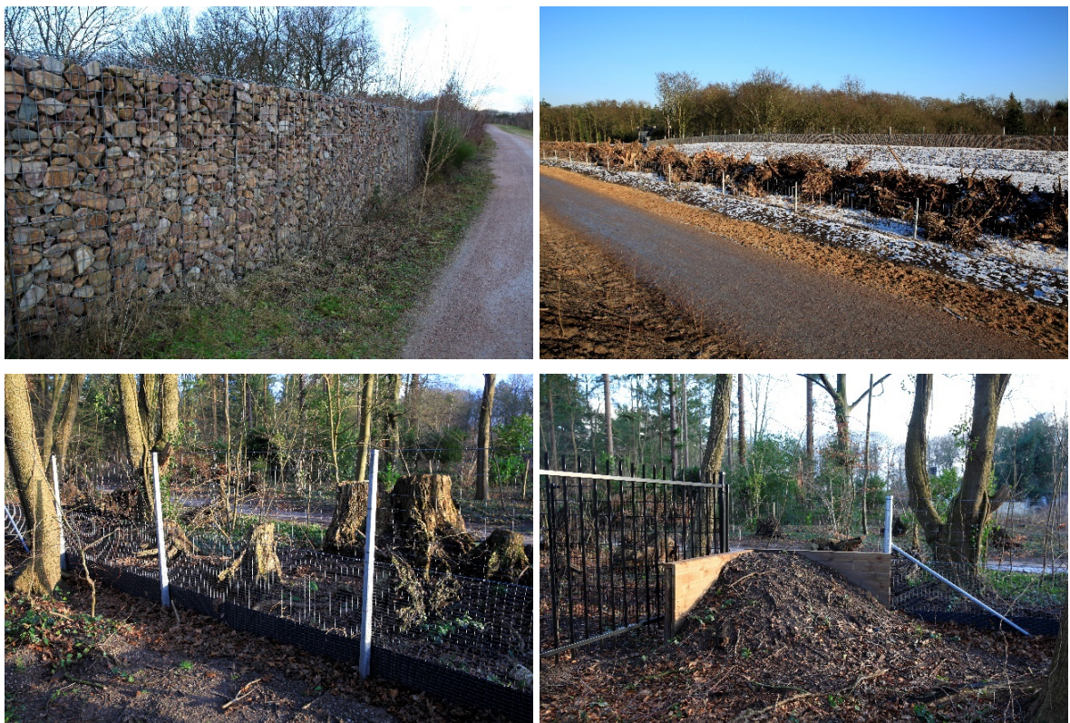
Figuur 8 Hoge muur van schanskorven aan de westzijde van de natuurbrug (linksboven), schanskorven met boven op een raster en een aarden berm op het ecoduct over de A1 (rechtsboven), faunakerend combinatieraster aan de noordzijde van de natuurbrug (linksonder) en een insprong nabij Corridor Prinses Julianalaan die dieren in staat stelt het raster te passeren (rechtsonder).
