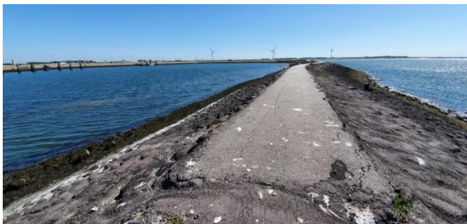
Figuur 7.60: Versterkte dijk met een cement laag.
