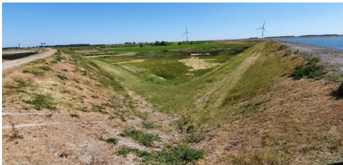
Figuur 7.59: Binnendijks is schraal grasland met op enkele plekken pitrusvegetatie aanwezig.
