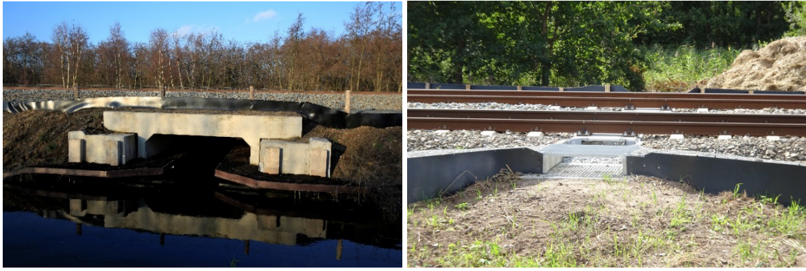
Figuur 3 Twee van de faunapassage in de spoorlijn die het Naardermeer doorsnijdt. © Foto's: Edgar van der Grift (links); Fabrice Ottburg (rechts).
