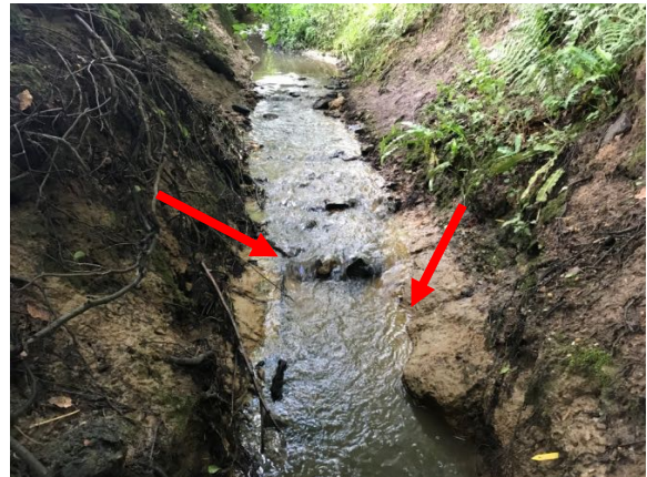
Raaien SV5 bout B14 35 mm erosie bodemval
