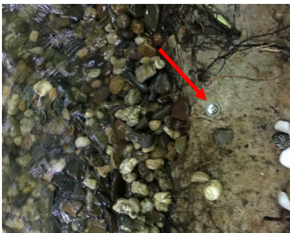
Afwerking en markering bout
