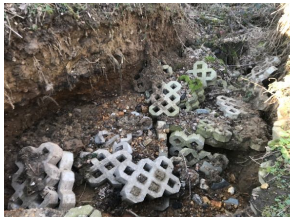
Grote grasbetonblokken hielpen niet
