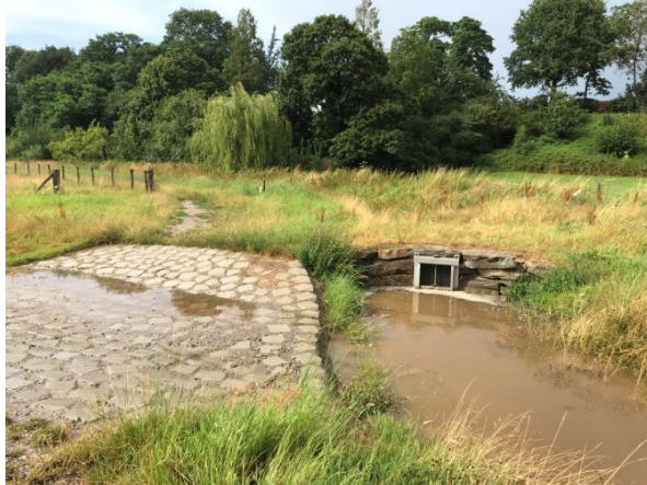
Drempel bovenstrooms grote buffer 17:21
