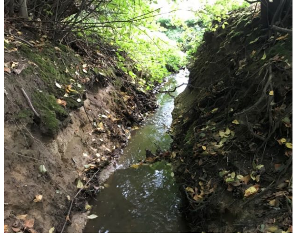
Overzicht traject bovenstrooms
