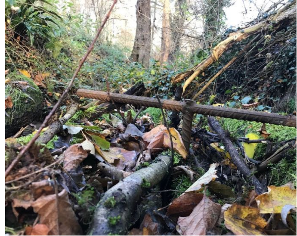
Gezakt houtpakket, ruimte tussen beugel
