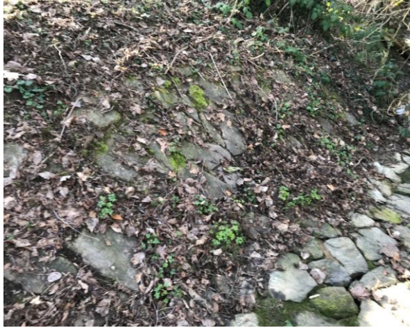
In beton gezette stenen tot de insteek
