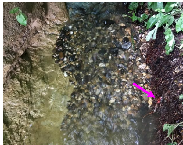
Matje 6 afgedekt met grind grondpen
