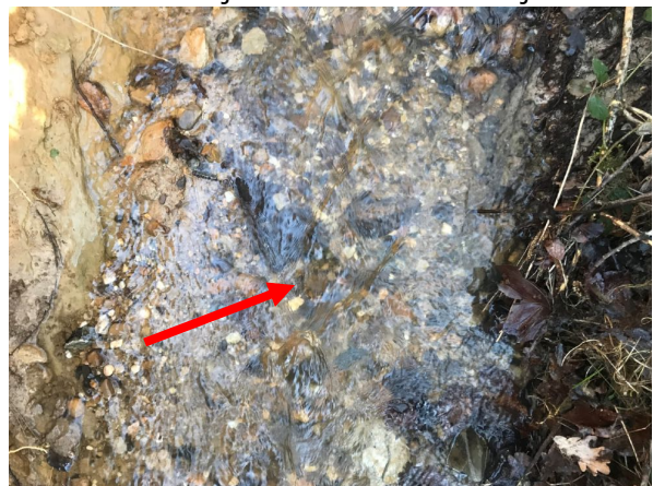
Stabiele bodemligging bij worteldoek
