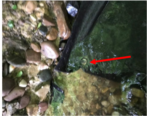
Verankering met een erosiebout
