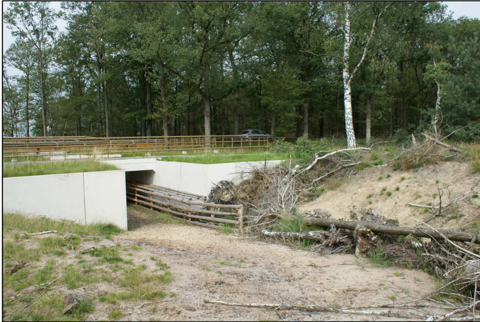
Figuur 4.2 Een middelgrote faunatunnel met voorzieningen voor reptielen (Foto: Dimitri Emond).
