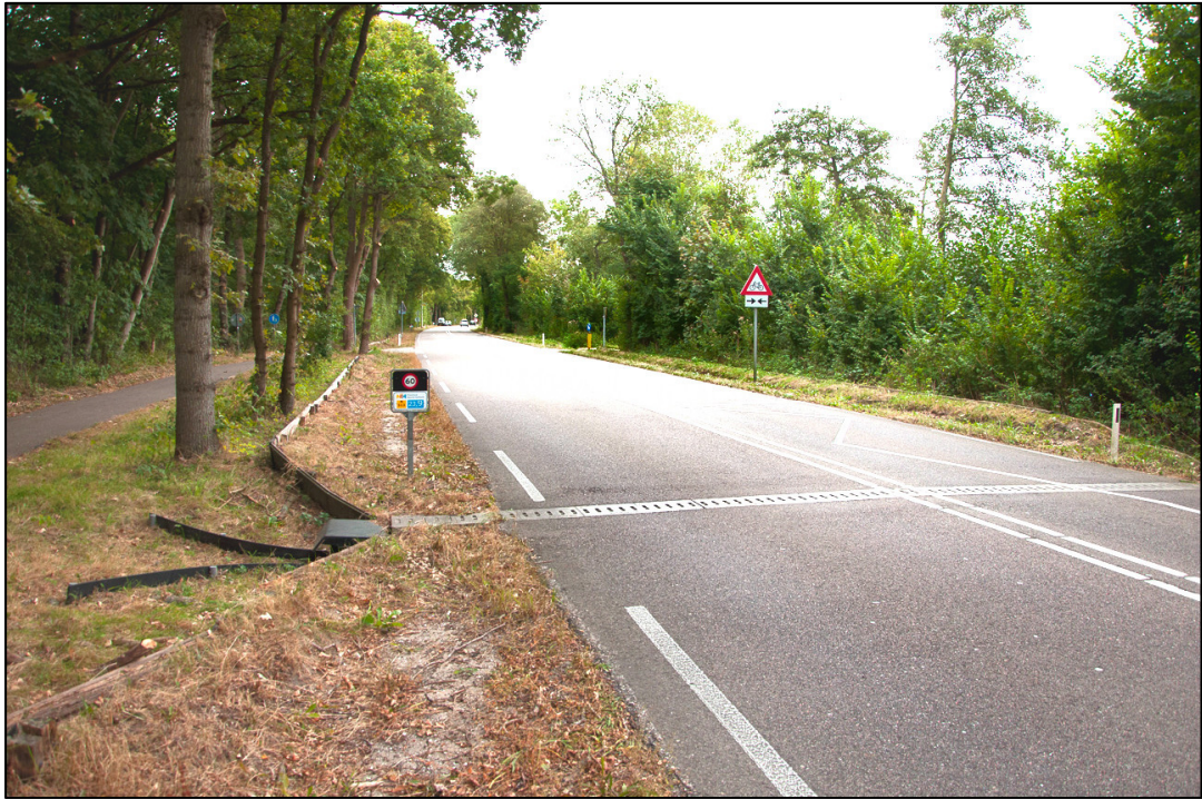
Figuur 2.10 Faunatunnel onder de N513. De houten schermen zijn in winter 2017 vervangen door plastic schermen (Foto: Dennis Wansink d.d. 26-09-2016).
