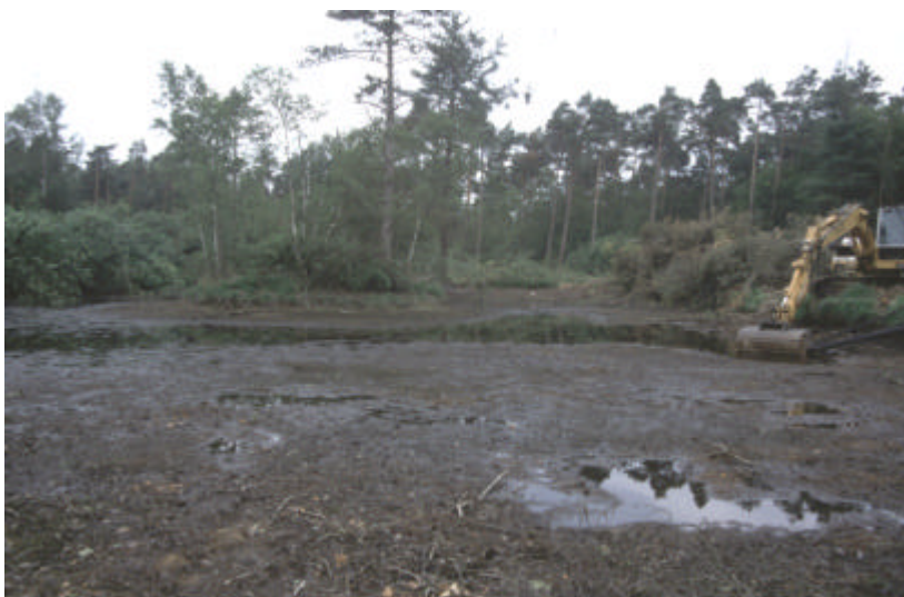
Foto 1: Herstelmaatregelen worden uitgevoerd in Verwolde
