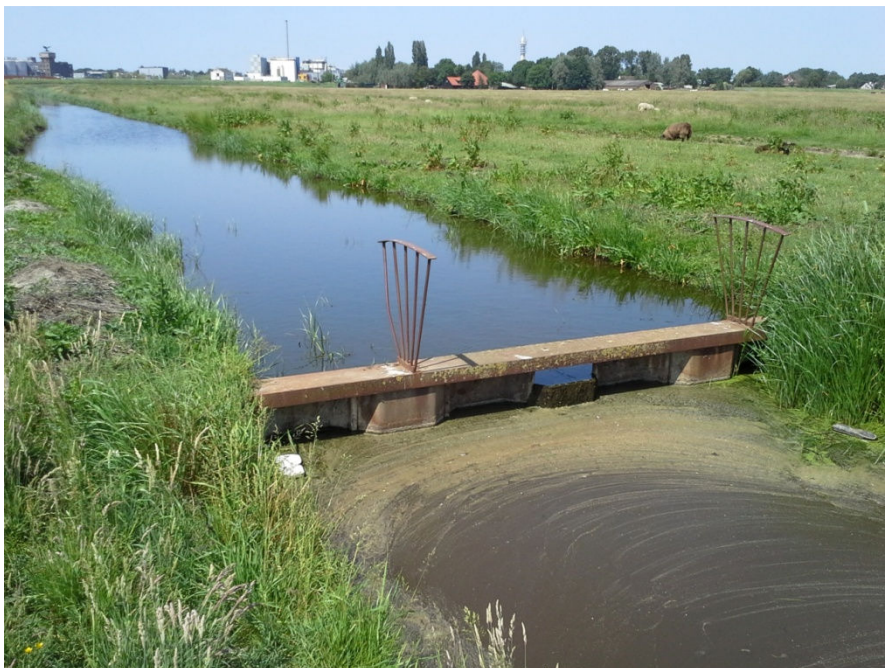
Figuur 42. Waterkerend schot in de Enge Wormer.
