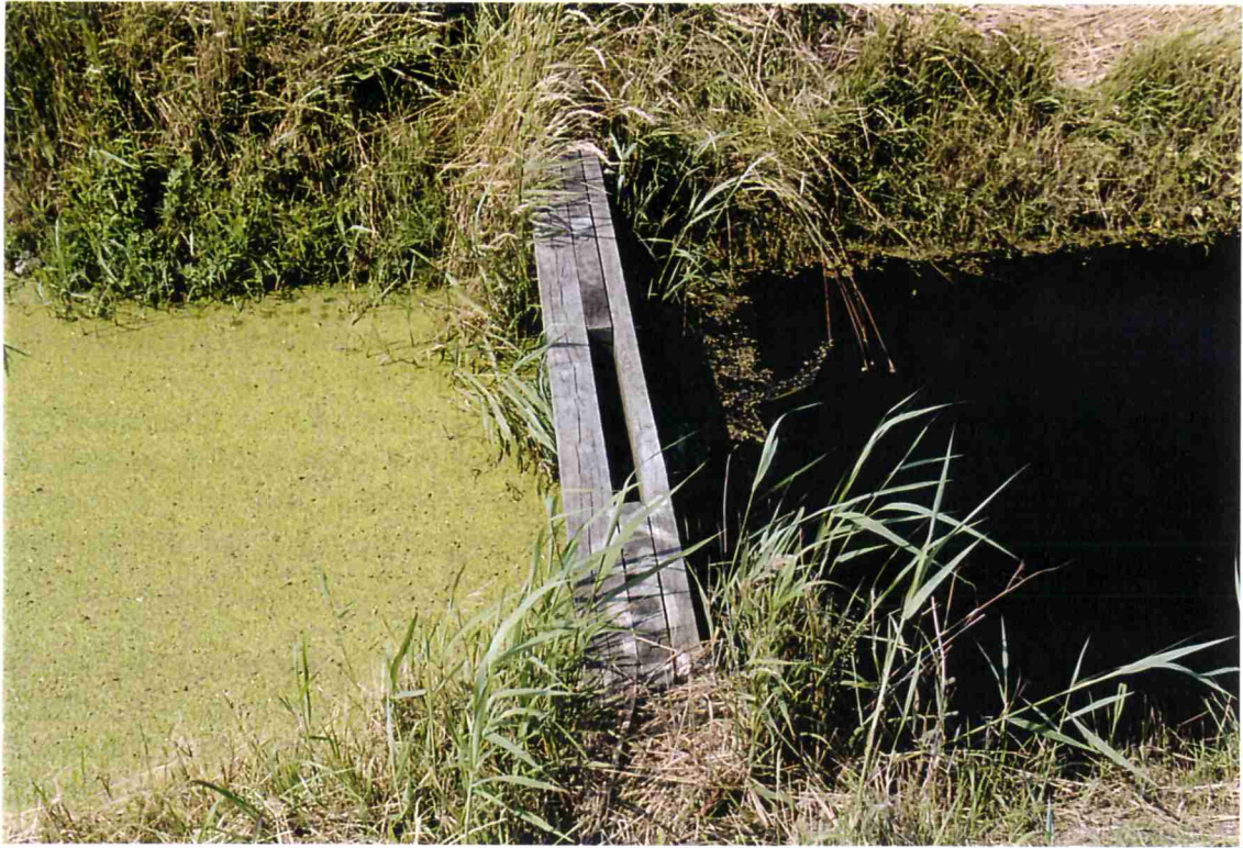
De isolatie van de sloot langs de Nollen (rechts) d.m.v. een damwand is een groot succes.
