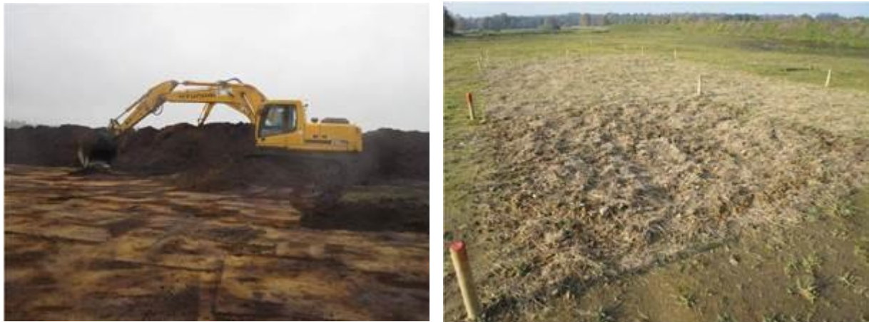
Figuur 2.4. Links: ontgroning van het Noordenveld, juli 2011. Rechts: één van de proefvlakken in het Noordenveld enkele maanden na ontgronden. In het hele proefvlak (8 x 16 m) is vers maaisel aangebracht. In het deelproefvlak linksonder in beeld is bodem aangebracht in de vorm van bodemkruimels. On the left: top soil removal in the Noordenveld, July 2011. On the right: one of the experimental plots. Fresh hay was applied in the entire plot (8x16 m). In the subplot down on the left also soil crumbs were added.
