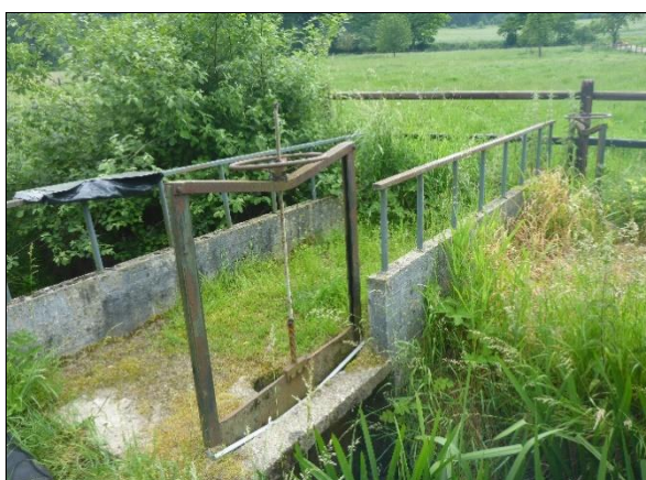
Foto: Waterverdeelwerkje bij Altenbroek, juni 2019 (foto H. de Mars)
