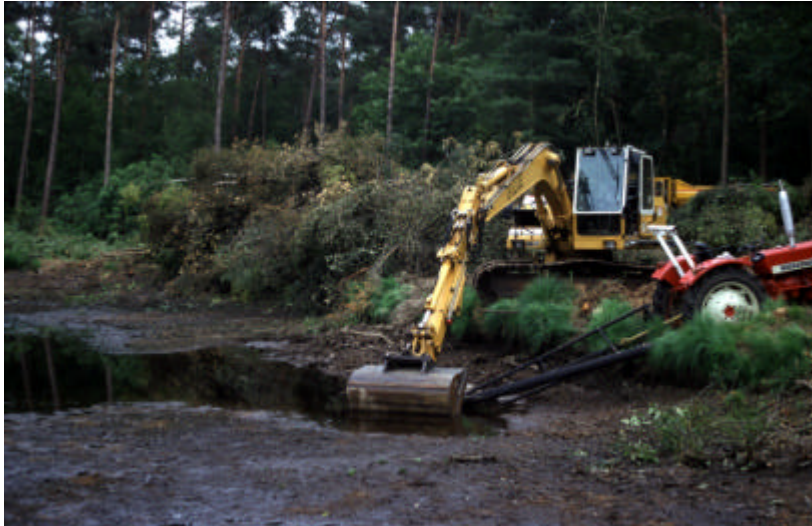
Foto 1: Herstelmaatregelen worden uitgevoerd in Verwolde.
