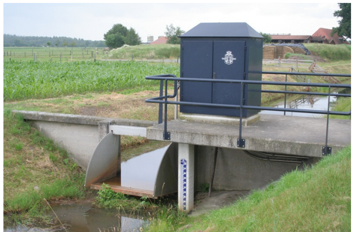
Figuur 8: Regelbare stuw van waterschap Regge en Dinkel in de Hoogelaarsleiding bij de Dwarsdijk aan de noordoostzijde van het Wierdense veld. Er vindt geen afvoer plaats, en het zuidelijke deel van de Hoogelaarsleiding staat droog (foto: Jos van Asmuth, d.d.: 12-7-2013)
