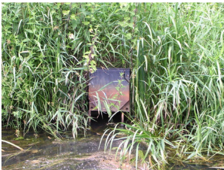
Figuur 8. 2. Juli 2003. Zo hoort het: het peil van de beek is lager dan de afvoerbuis, waardoor wateraflaat vanuit het Koelbroek plaats kan vinden.
