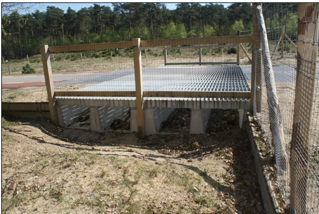
Afbeelding 3.4. Wildrooster met vier faunatunnels bij de N804 (Deelen – Hoenderloo) voor doelsoort reptielen en andere fauna waaronder amfibieën. In de afzonderlijke tunnels zijn stammetjes aangebracht als dekking en geleiding (D. Emond).
