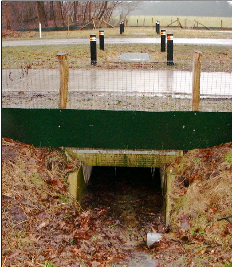
Afbeelding 3.2 Amfibieëntunnel onder provinciale weg in Noord-Brabant (G. Smit).
