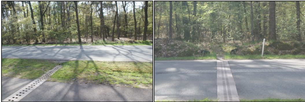
Afbeelding 3.3. Amfibieëntunnels bij de N310, Otterlo. Links een 'gesloten' constructie (wel open in tussenberm en fietspad) en rechts een 'open' constructie (D. Emond).
