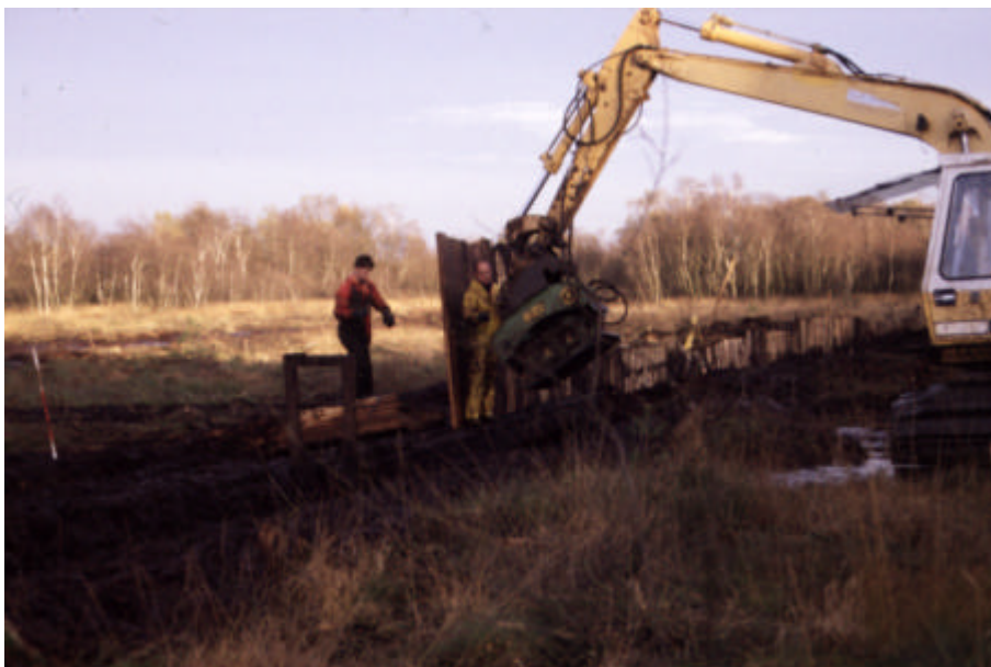
Hoogveenrestauratie in het Meddose Veen (onderdeel van het Korenburgerveen) waarbij damwanden in het veen worden geslagen tot op de minerale bodem. Foto: Wilco Verberk.
